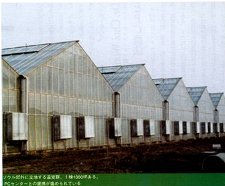
太陽光と外気温をセンサーが感知して遮 幕が開閉する
